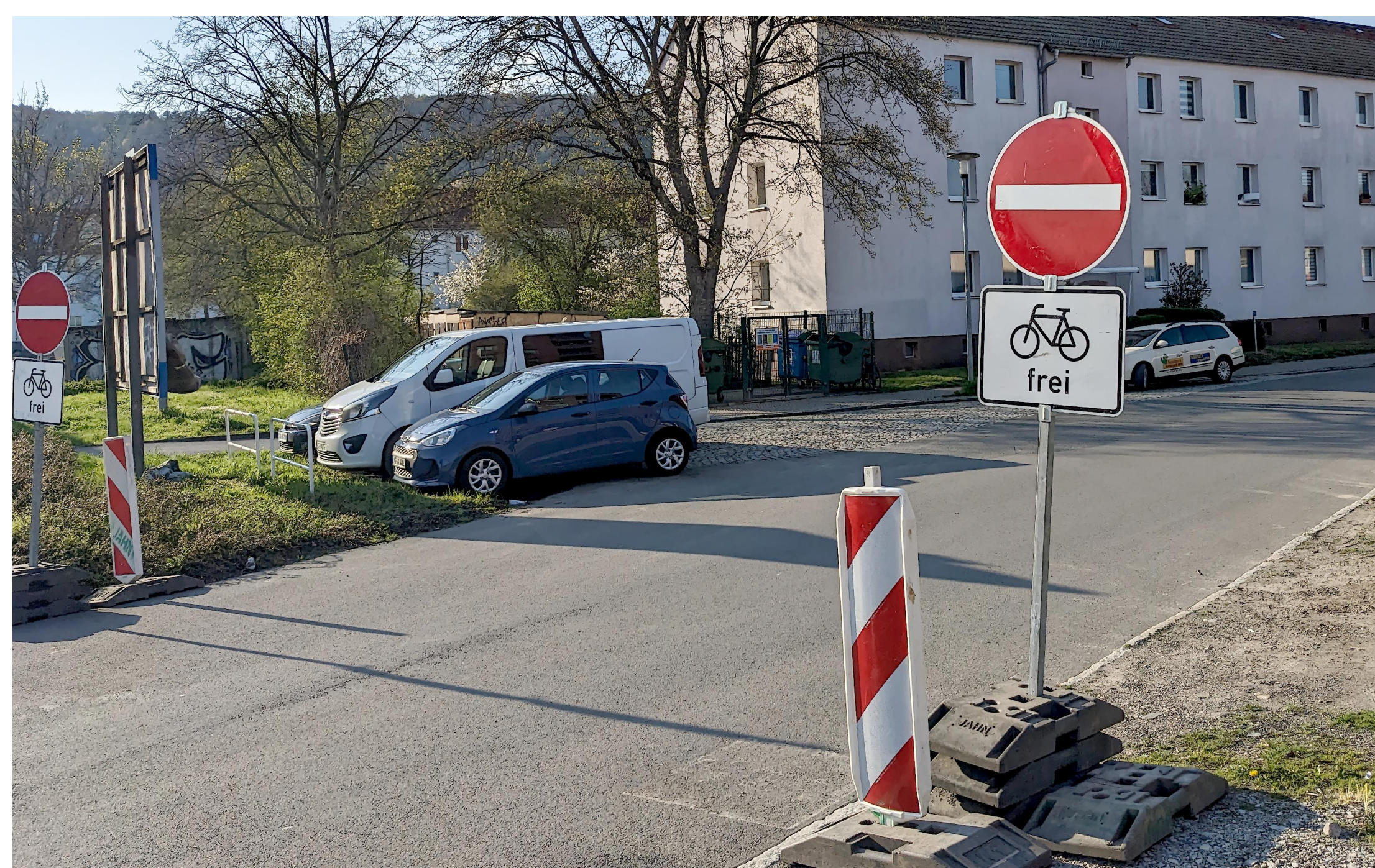
Baustelle Spitzweidenweg, April 2023
