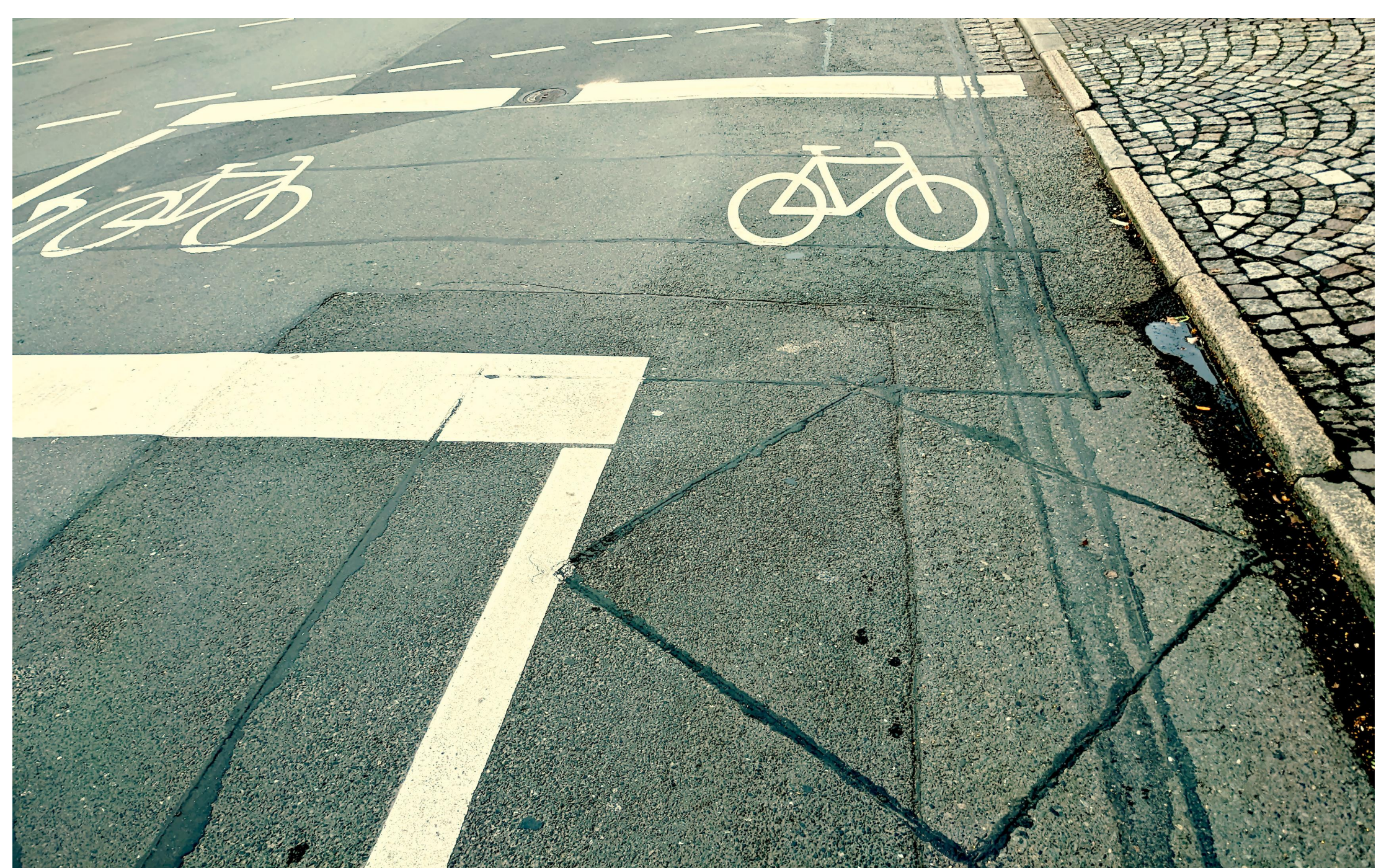
Induktionsschleife für Radverkehr (Nollendorfer Straße)
